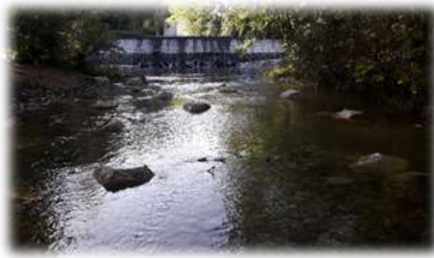
Figure 22 : Site de l'Isle en Dodon après travaux
