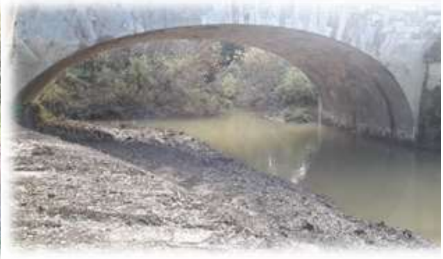
Figure 20 : Atterrissement de l'Isle-Jourdain (après travaux)
