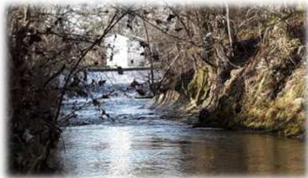
Figure 21 : Site de l'Isle en Dodon avant travaux
