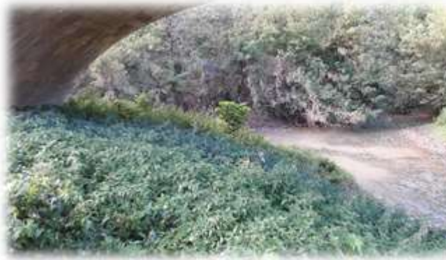
Figure 19 : Atterrissement de l'Isle-Jourdain (avant travaux)
